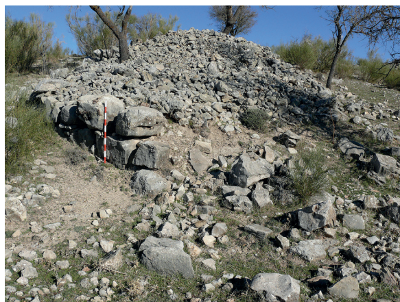
Fig. 4: Ángulo oriental de una de las puertas de la ciudad, flanqueada por un torreón con grandes sillares de aspecto ciclópeo. © J. A. Pachón, 2009.
